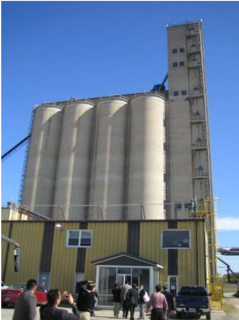
リバーエレベータ 事務所入り口
